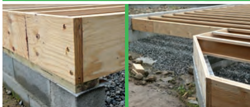
Poutres de rives de dalles bois
