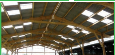
Fermes 2 pentes sur poteaux avec ou sans auvent
