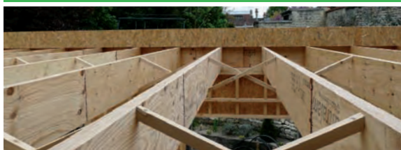
Chevrons solives support de toiture terrasse - linteaux
